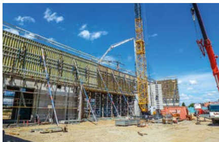
Rasch und präzise werden Bauaufträge umgesetzt.
