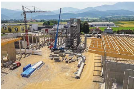
Baustellen werden hochprofessionell abgewickelt.
