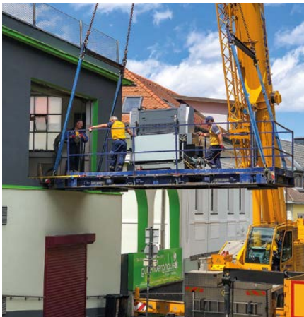
Zwei Kräne waren für den Transport notwendig.
